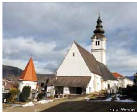
Unsere Ruprechtkirche erstrahlt nun wieder ohne Gerüst und mit sanierter Fassade! Zementhaltige Putze und kunststoffhaltige Dispersionsfarben aus den 1970er Jahren hatten die Substanz derart zerstört, dass durch herabfallenden Putz Gefahr im Verzug war.
